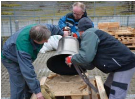
Die Spezialisten der Turmuhrfirma bereiten mit dem Kranführer (links) die Glocke für die Hängung vor.
