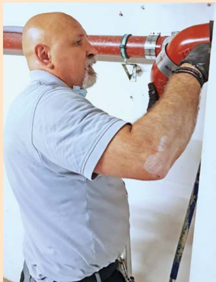
Lajos Szabo auf der Baustelle in der Notburgastraße 10
