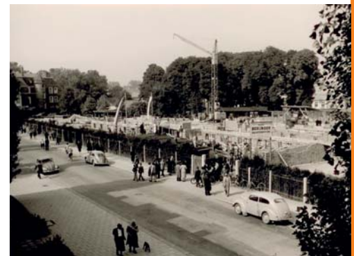
Baustelle für den Neubau Ende 1955
