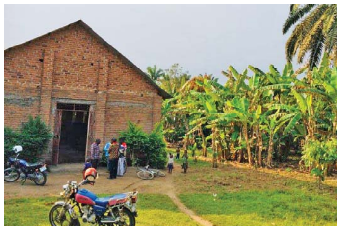
Eine Kirche der Partnergemeinden des Prodekanats München West, in der künftig unter der Woche ein Kindergarten sein Zuhause finden soll, ein Toilettenhaus, finanziert mit Hilfe aus München ist im Bau.
