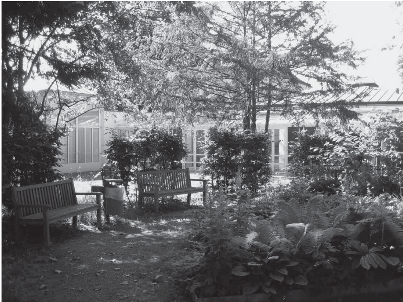
Der Blick vom Krankenhausgarten auf die Erweiterung der Palliativstation lässt die Ruhe und Fürsorge sowie die angenehme Atmosphäre erahnen, die die schwerkranken Patienten in dem neuen Anbau erwartet. ck
